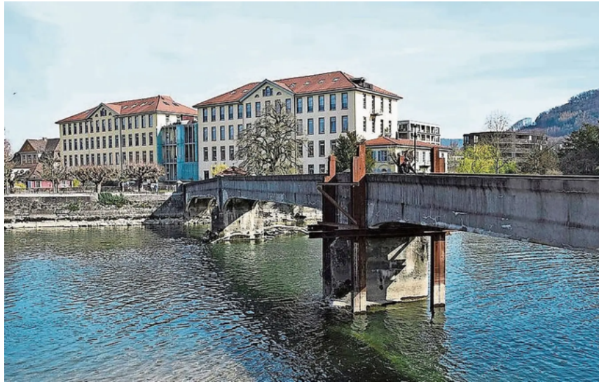
Die Spinnereibrücke wird seit einiger Zeit provisorisch gesichert.
