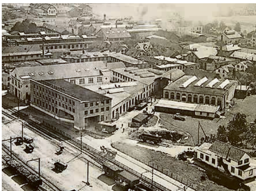
Aeschbachhalle 6 in Aarau, ein historisches Gebäude, heute umgeben von moderner Architektur.
