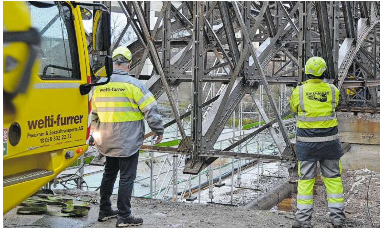
Schwere Last Ein mobiler Kran bugsiert bei Wind und Regen die Eisenbrücke von ihrem angestammten Platz.
