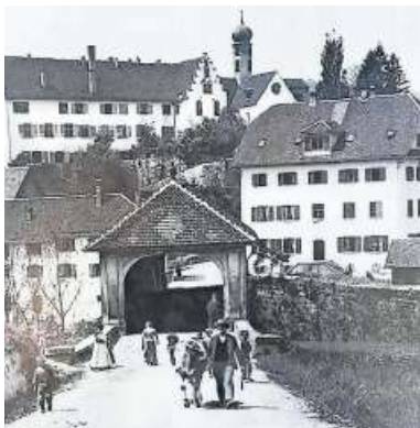
Antik Die Brücke früher.
