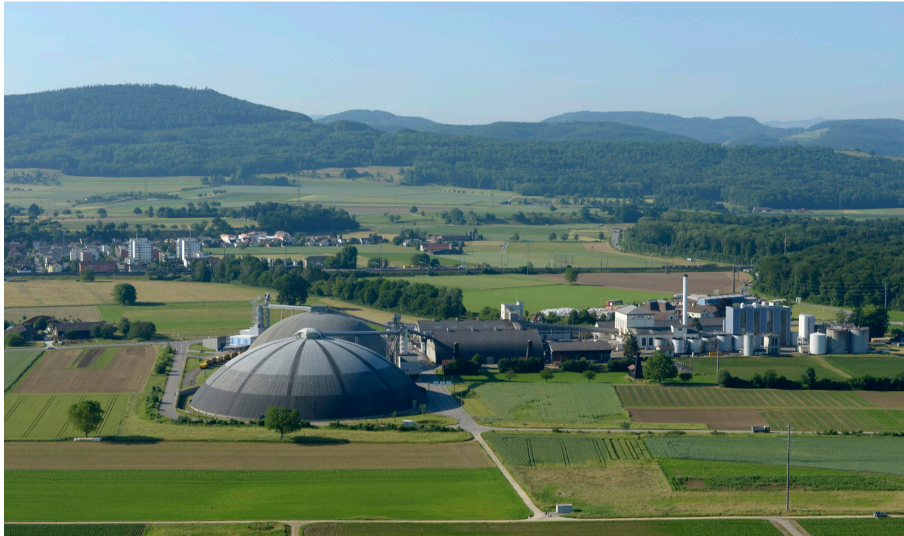
In Riburg wird Lose-Salz abgebaut, an die Kunden ausgeliefert oder in den zwei Silos gelagert.
